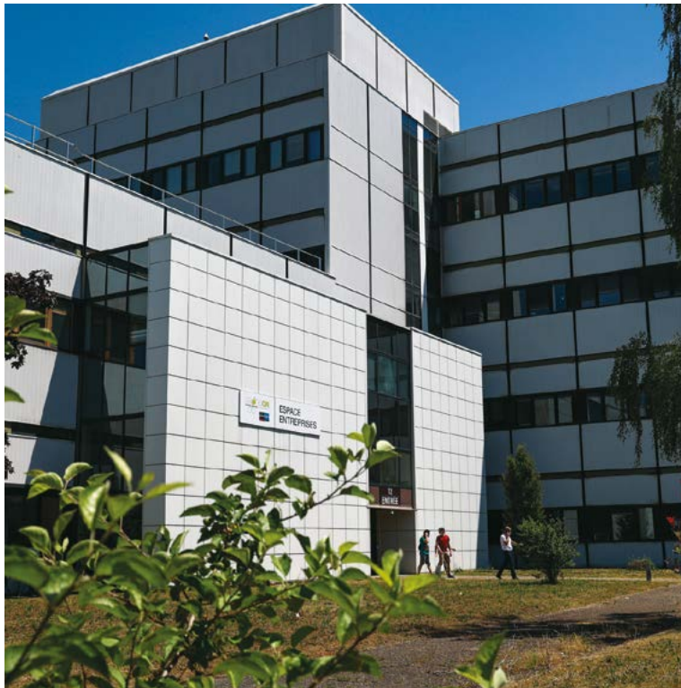
L'Espace Entreprises héberge 82 entreprises
